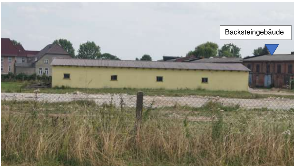
Bild Nr. 15: Backsteingebäude für die Anbringung der Ersatzkästen
