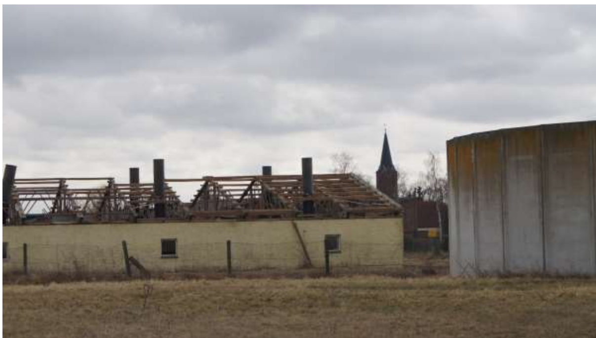
Bild Nr. 06: Stallruine im Zentrum und Güllebehälter im Westen des Plangebietes
